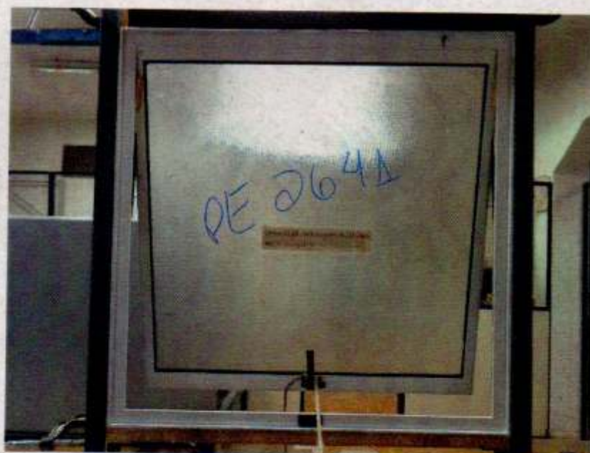
Foto nº. 02 Arrancamento das articulações.
